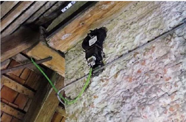
**Bild 6b** LM-S Blitzstromsensor im Uhrnturm in Graz, Österreich
