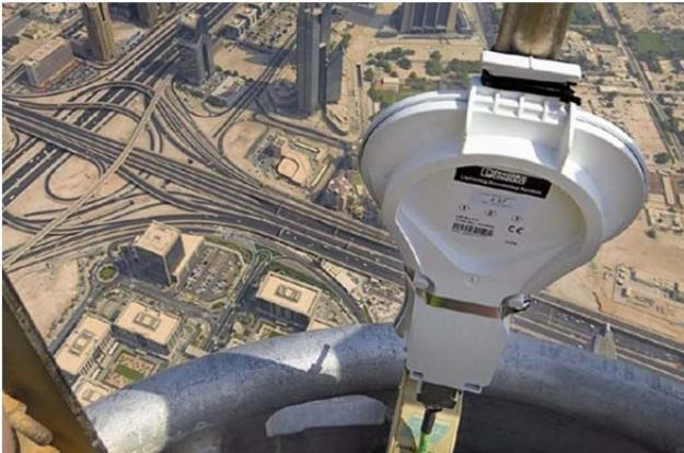
**Bild 3b** LM-S Blitzstromsensor auf dem Burj Khalifa in Dubai, Vereinigte Arabische Emirate
