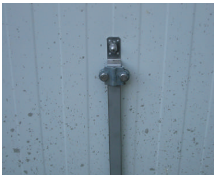
Bild 5: Anschluss einer Metallfassade
