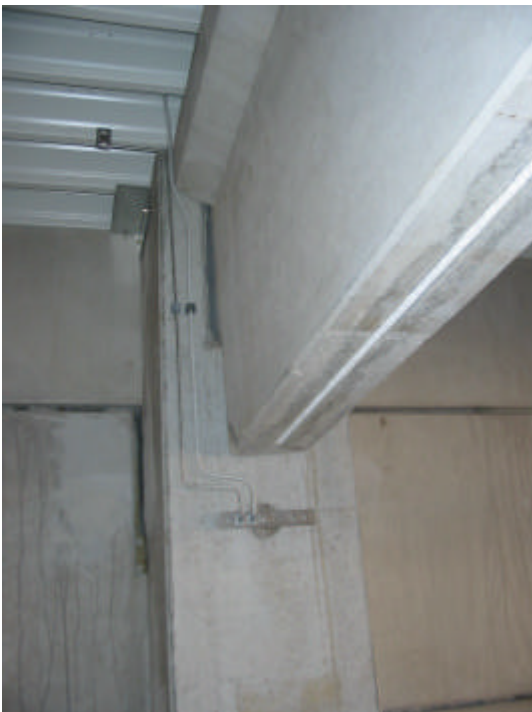
Bild 7: Anschluss der metallenen Dachtragekonstruktion
