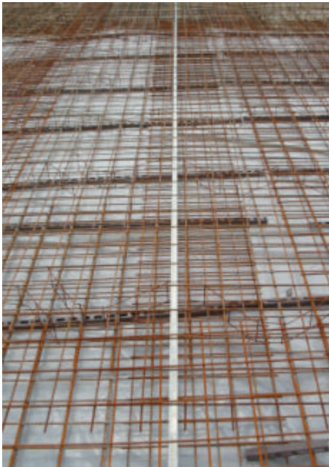
Bild 1: Fundamenterder auf Bewehrung
